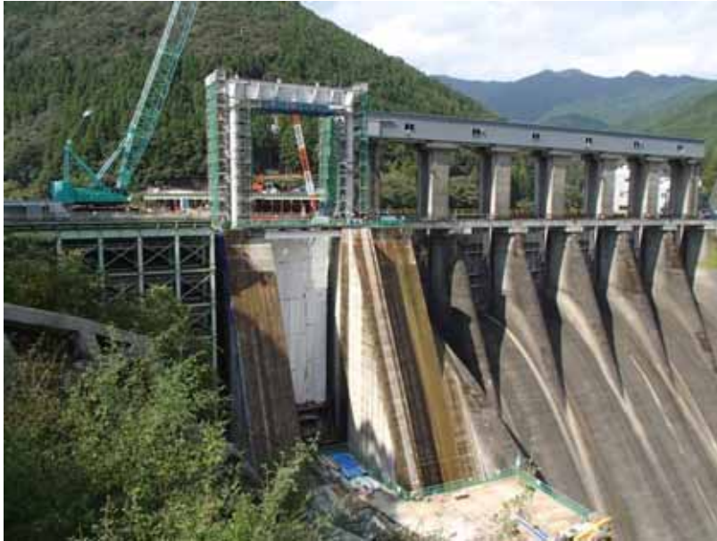
ダム下流面 (H29年9月撮影)
