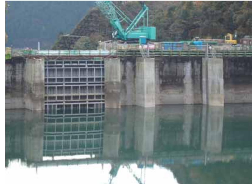
ダム上流面 (H28年12月撮影)
