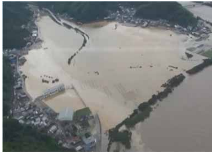
浸水状況(平成26年8月10日)
