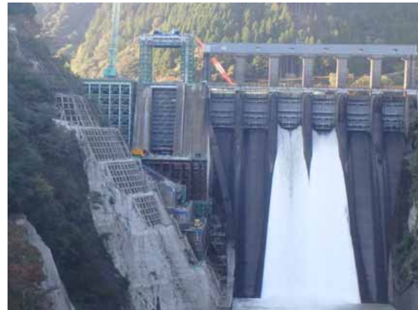
下流面全景 (平成29年10月撮影)
