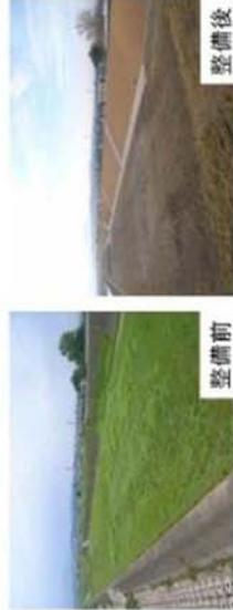
堤防漏水対策(川表断面拡大工法)の実施事例(大京原箇所)
