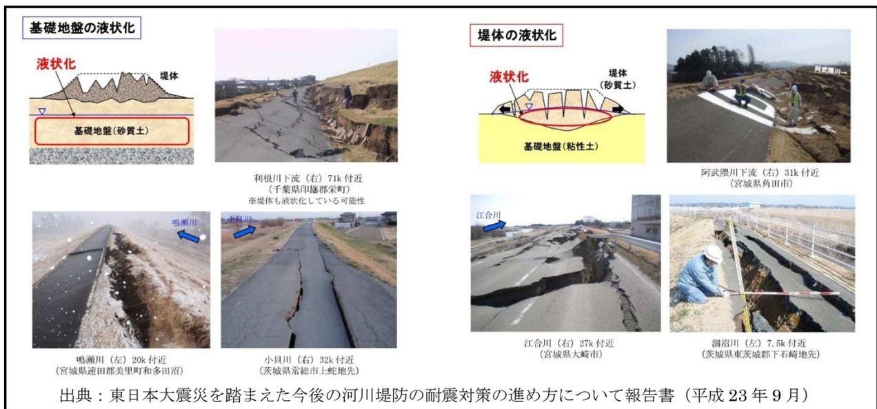
図6.1 東日本大震災における液状化による堤防の被災事例
