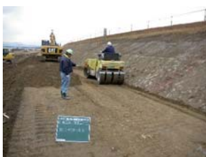
①川表断面拡大工法 施工状況写真
