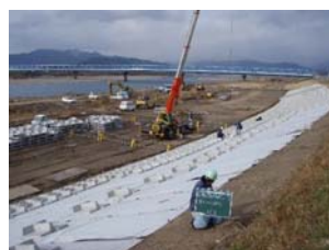
②表のり面遮水工法 施工状況写真
