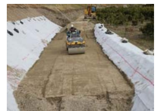
④裏のり置換工法 施工状況写真
