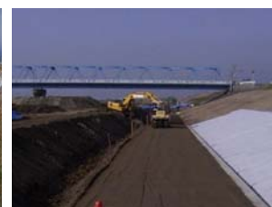
③ブランケット工法 施工状況写真
