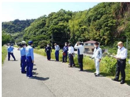
洗堀箇所の点検状況
