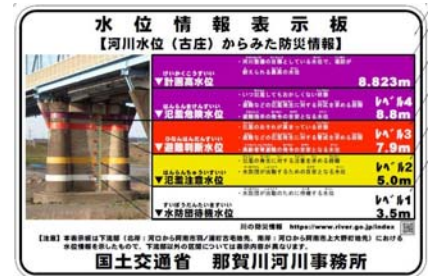
那賀川橋の説明看板
