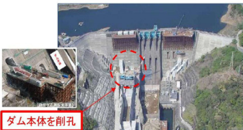
鶴田ダム再開発事業（鹿児島県薩摩郡さつま町）
