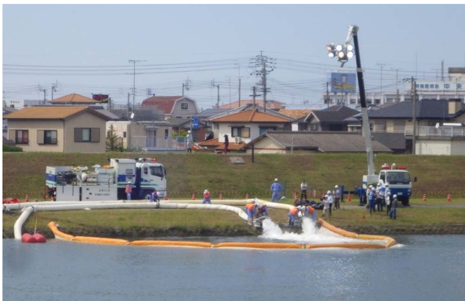
排水ポンプ車訓練実施状況
