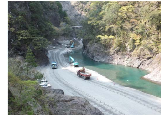
堆砂除去工事状況
