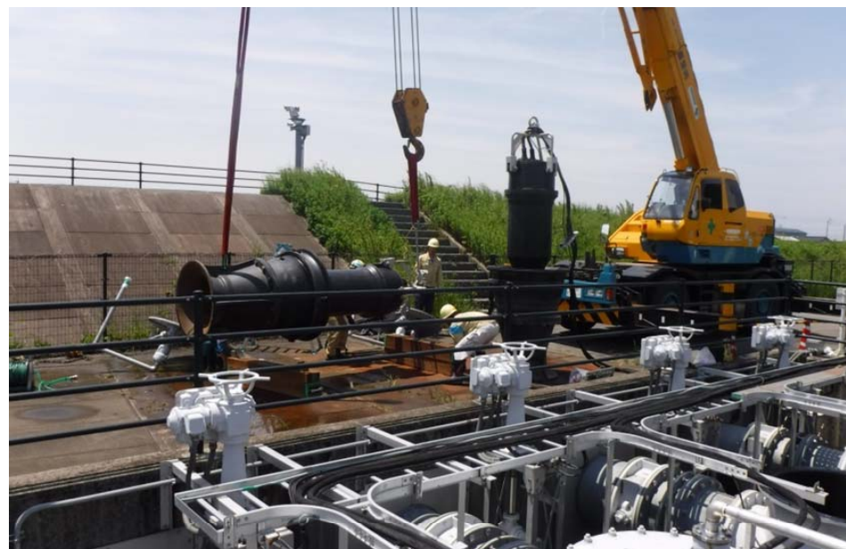
排水機場ポンプ点検状況
