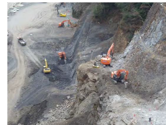
右岸地山掘削状況
