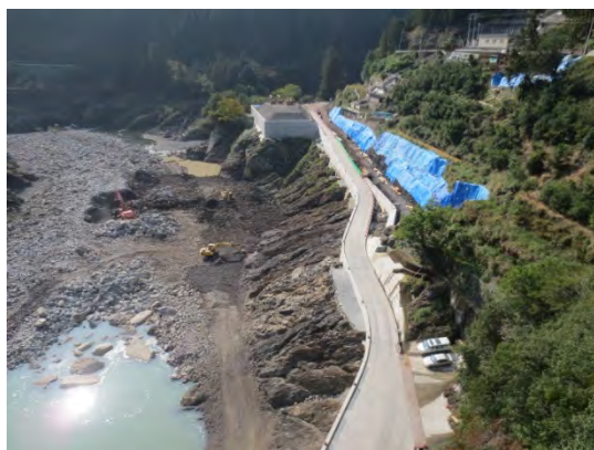
工事用道路の施工状況④
