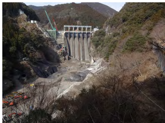
下流より既設堤体方向を望む
