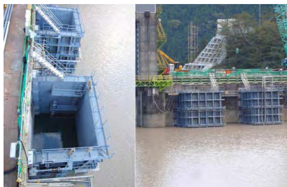
仮締切設置状況
