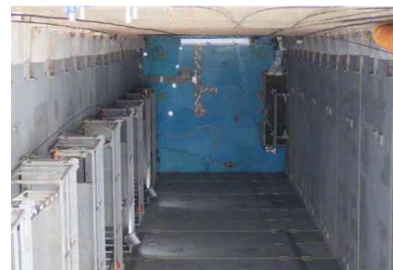
仮締切内部状況
