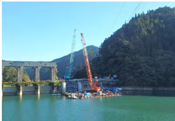
貯水池構台より堤体上流部を望む
