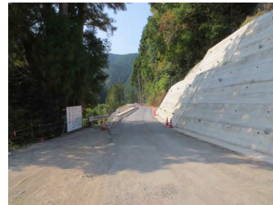
工事用道路の施工状況③
