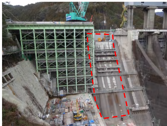
既設堤体切削状況
