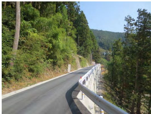
工事用道路の施工状況①
