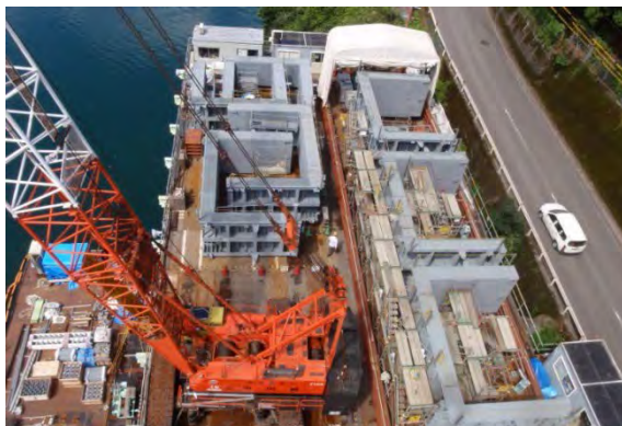
仮締切組立状況
