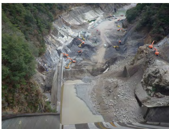
減勢工全体(天端より)
