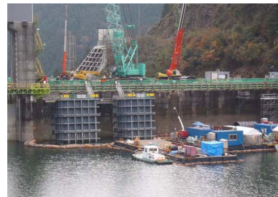
仮締切設置状況
