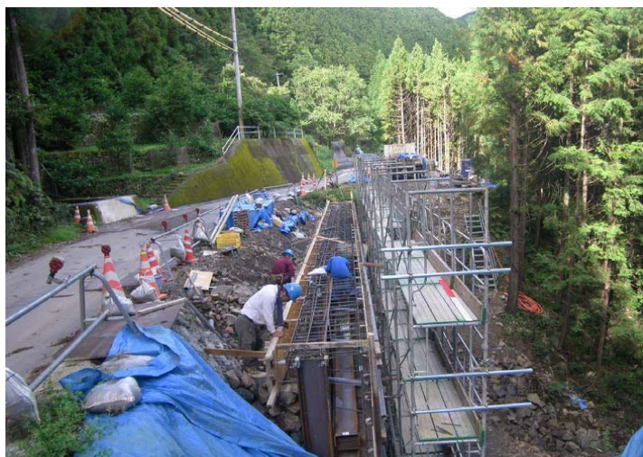
工事用道路の施工状況
