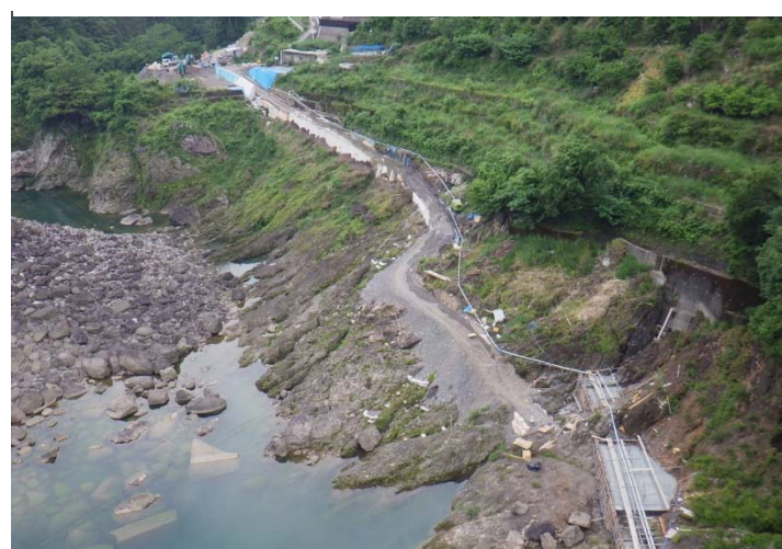
工事用道路の施工状況
