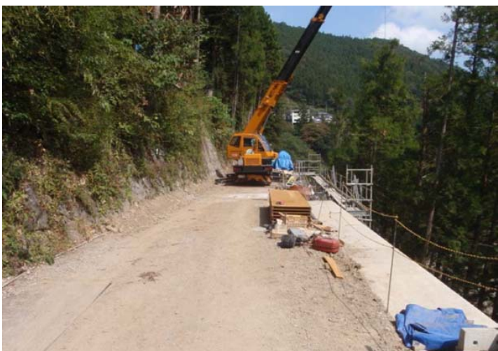
工事用道路の施工状況
