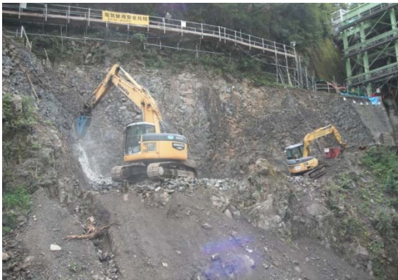
地山掘削状況
