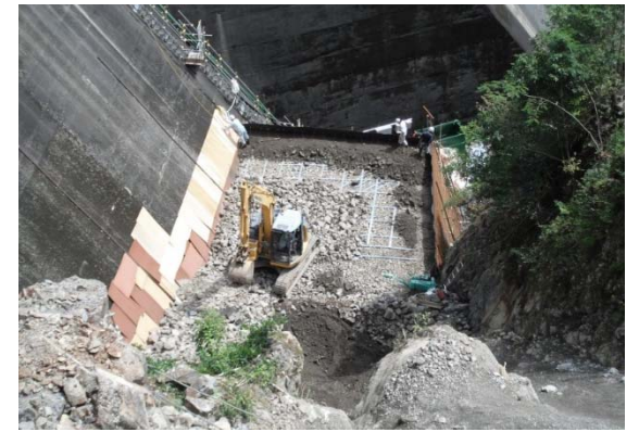
掘削ズリ仮置き状況
