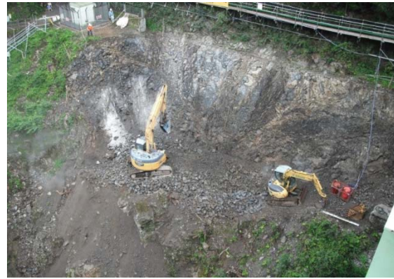
地山掘削状況
