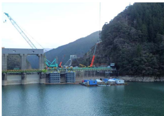
貯水池構台より堤体上流部を望む
