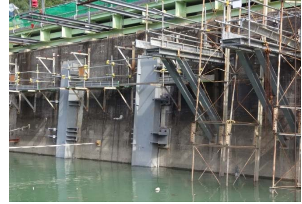
側部戸当り設置状況
