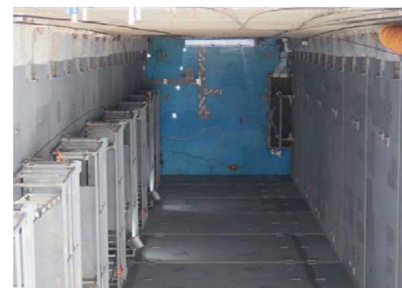
仮締切内部状況
