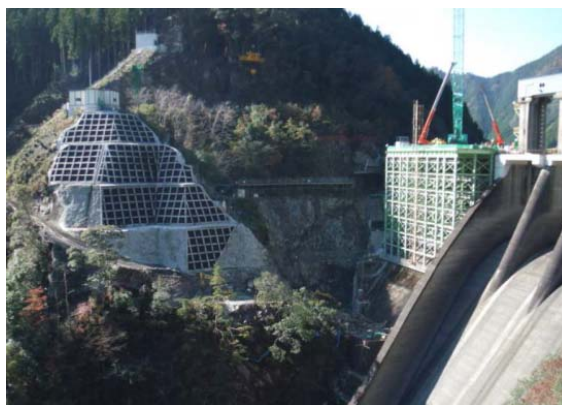
左岸下流より右岸下流部を望む
