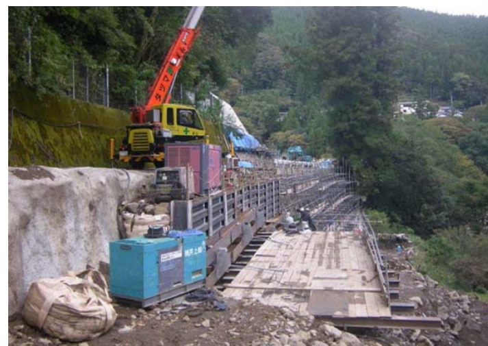
工事用道路の施工状況
