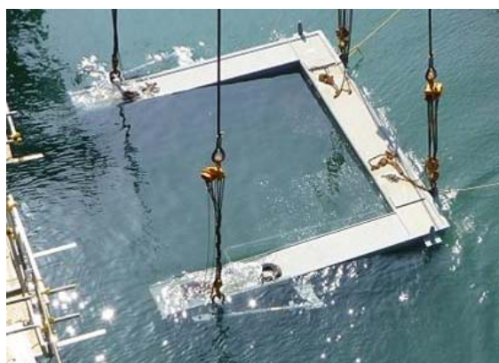
仮締切設置状況
