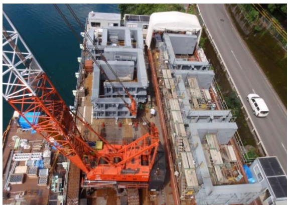
仮締切組立状況
