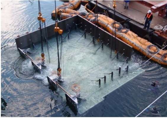
底部架台設置状況
