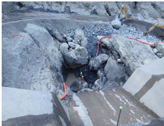
放水後、転石・堆積物確認
