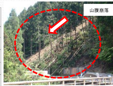
③H27.4月、県道日和佐上那賀線山腹崩落発生(工事用道路施工に影響)
