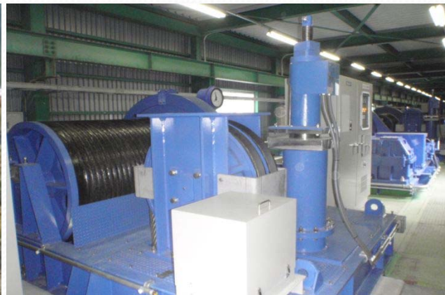
1号開閉装置設置完了
