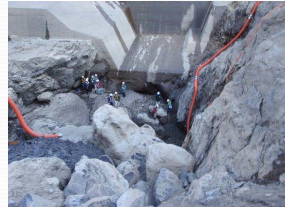
放水後、転石・堆積物確認
