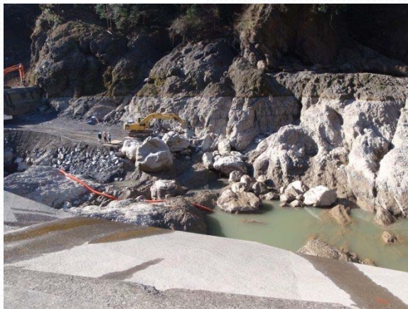
放水後、転石・堆積物確認
