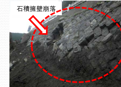
②H26.8月、県道日和佐上那賀線崩落発生(工事用道路施工に影響)
