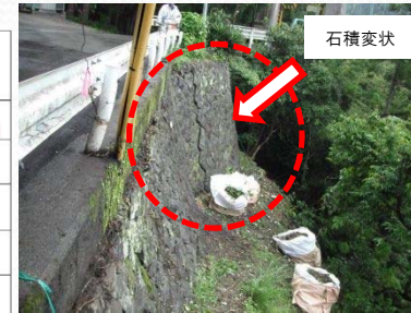
①H26.6月、町道谷口線変状発生(右岸法面掘削に影響)
