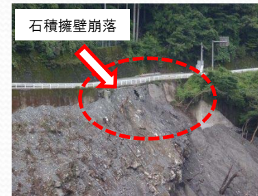
②H26.8月、県道日和佐上那賀線崩落発生(工事用道路施工に影響)
