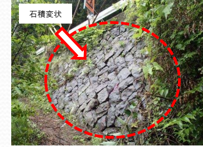
①H26.6月、町道谷口線変状発生(右岸法面掘削に影響)
