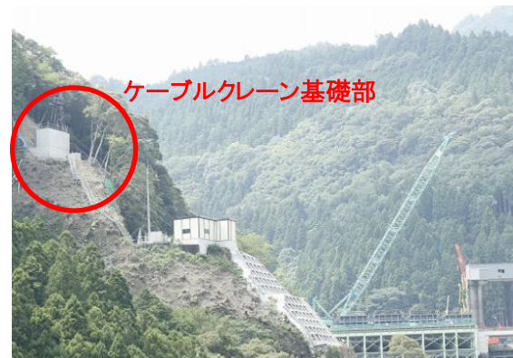
■基礎部を活用し、展望スペース整備
