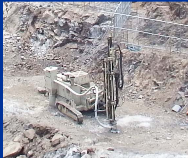
発破を利用したの岩掘削 火薬充てんの為のクローラードリル
