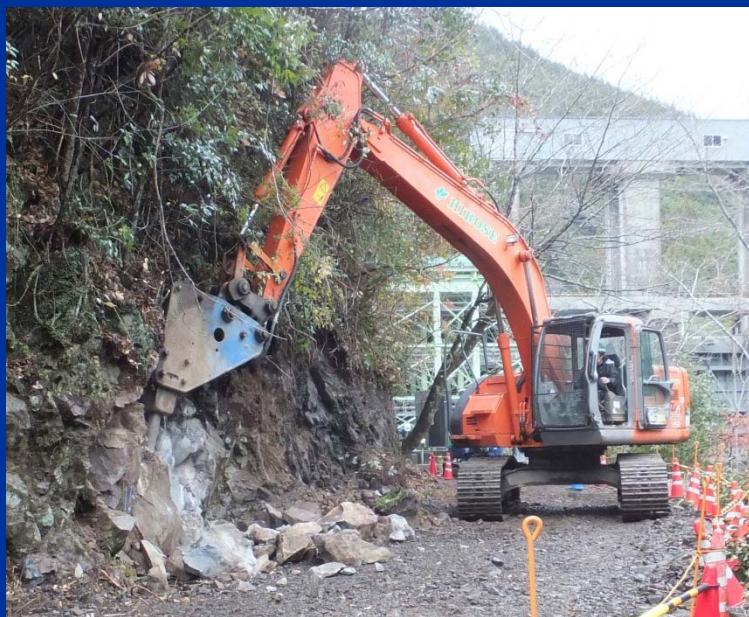
ブレーカによる掘削
