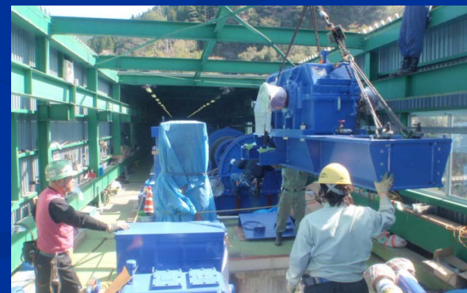
開閉装置の更新状況 (H24実施)
