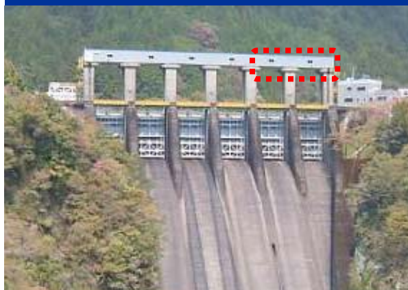
1・2号ゲートの 開閉装置更新
