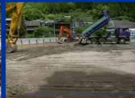
土砂の活用状況 (平谷地区防災ヘリポート)
