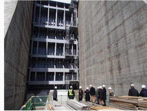
関東・近畿地整 （川側新設洪水吐ゲート下流）
