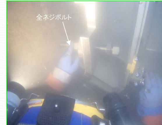
堆砂防護壁設置(潜水作業)
