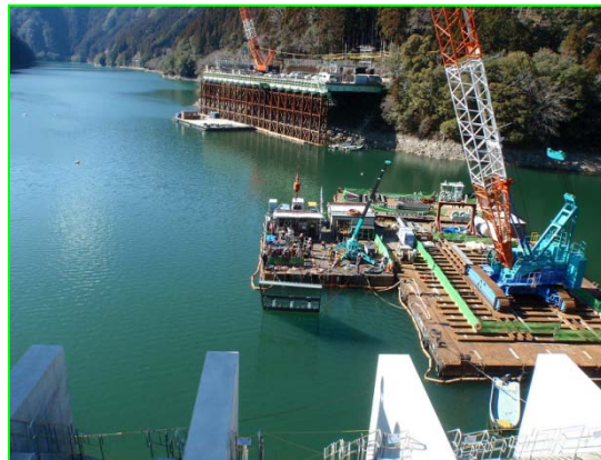
貯水池上作業状況(120tCC台船および船団)
