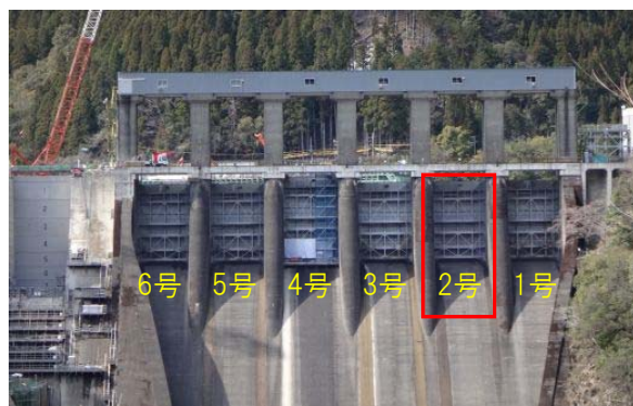
既設主ゲート設備補修
