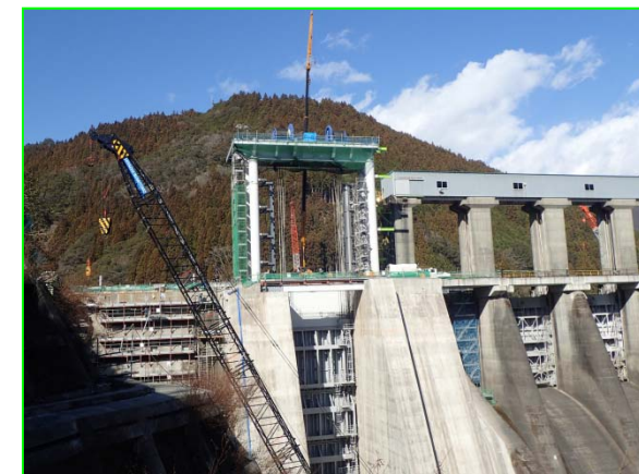
川側門柱門構据付完了(10BL)
