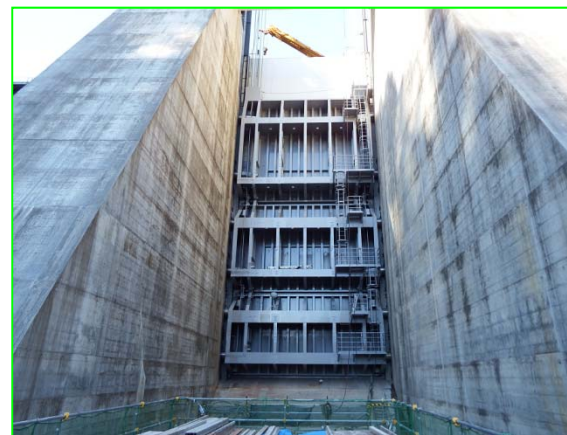
川側主ゲート(可動)据付完了(10BL)
