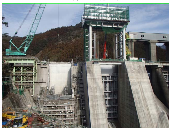
11BL: 堤体切削施工状況
