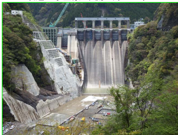
改造工事全景: 下流より(H29.4)
