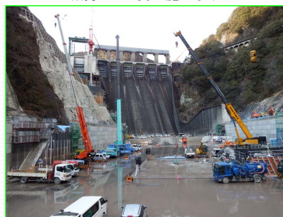
減勢工Pca側壁施工状況
