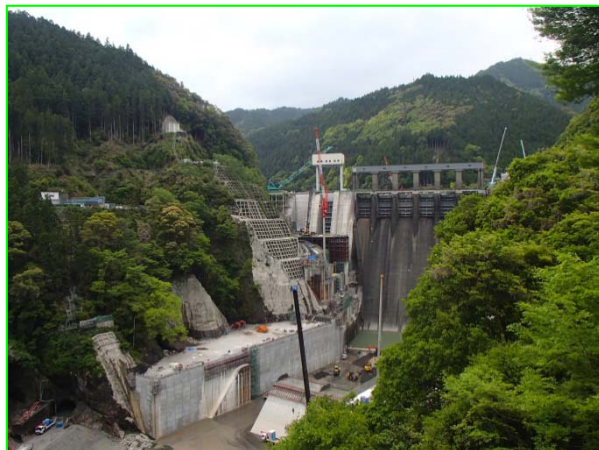
進捗状況(H30.4月末)左岸下流より
