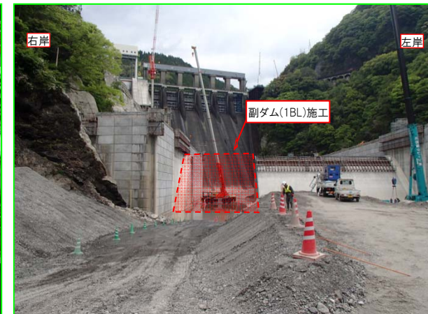
減勢工：施工箇所(下流より)
