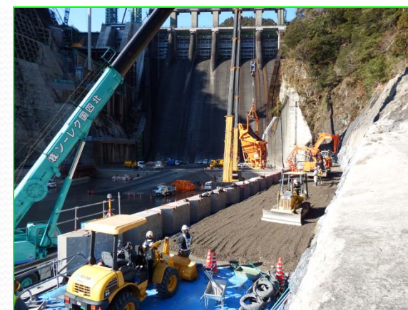
減勢工Pca側壁背面改良土埋戻し
