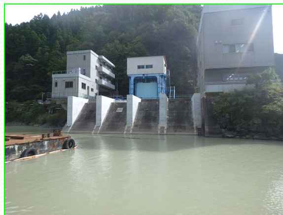
操作室下部工支持ピア完了
