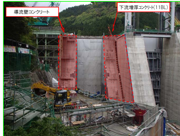
堤体工：施工箇所(下流より)
