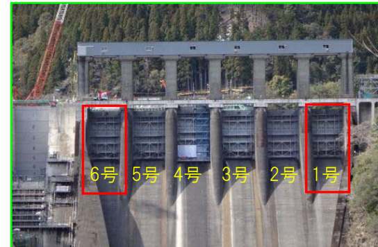
既設主ゲート設備補修 【施工時期】
