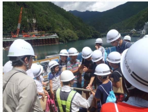
那賀町子どもまつり (天端仮設構台)
