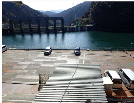
11BL仮締切撤去完了
