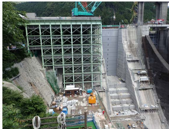
10BL堤体切削完了(H28.6)
