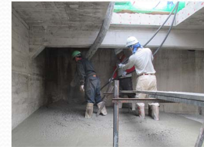
背面基礎コンクリート(気中)
