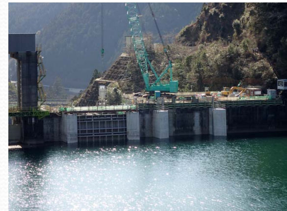
11BL予備ゲートピア設置完了
