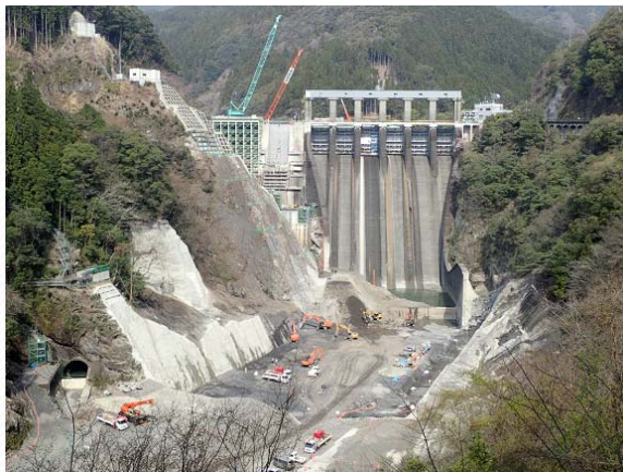
改造工事全景：下流より(H28.4)
