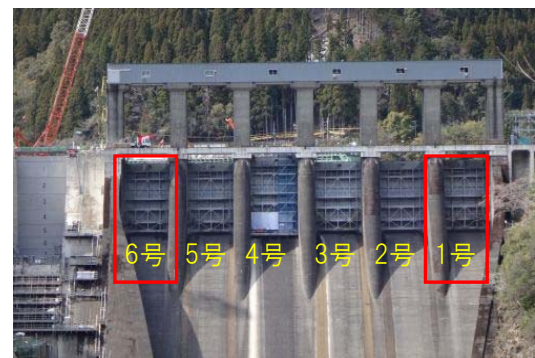
既設主ゲート設備補修
