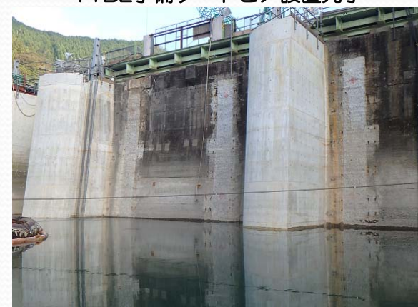
11BL予備ゲートピア設置完了
