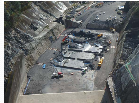
減勢工深掘部穴埋め状況
