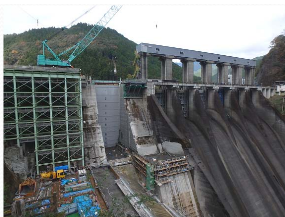
増厚コンクリート施工状況(10BL)
