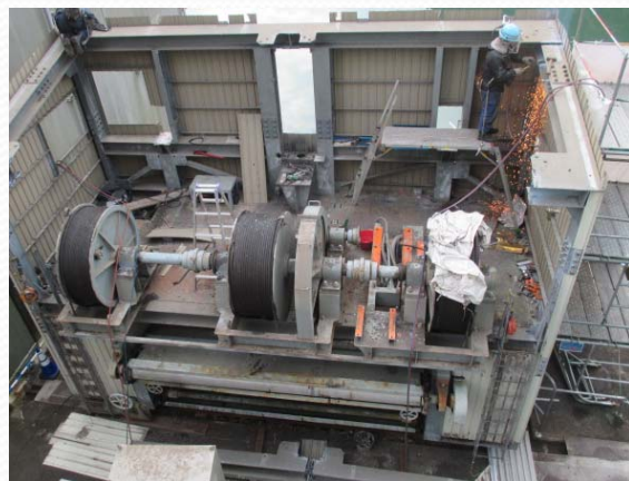
除塵機設備撤去状況
