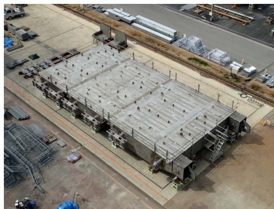
川側主ゲート(可動)製作完了(10BL)
