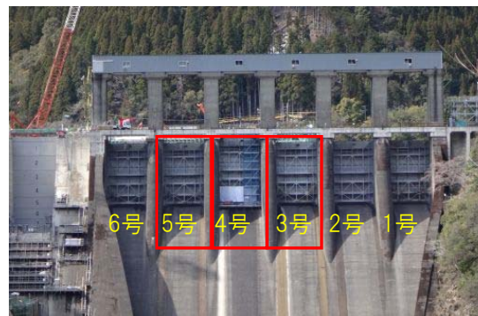
既設主ゲート設備補修
