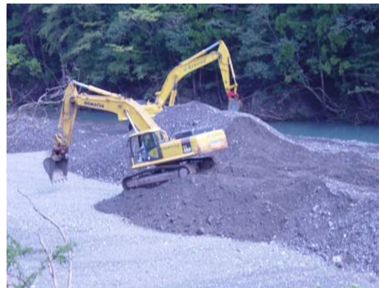
長安口ダム上流での掘削による土砂の除去
