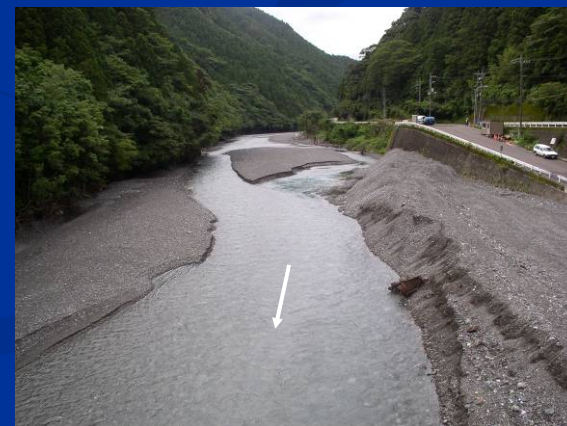
長安口ダム上流の堆砂状況
