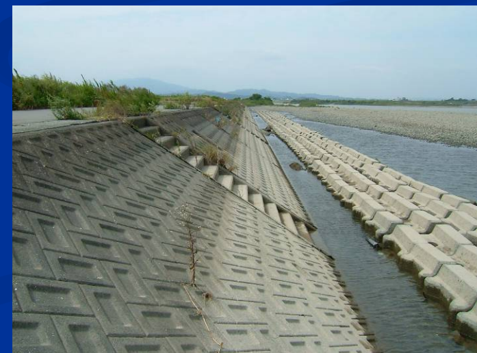
連続した根固ブロック
