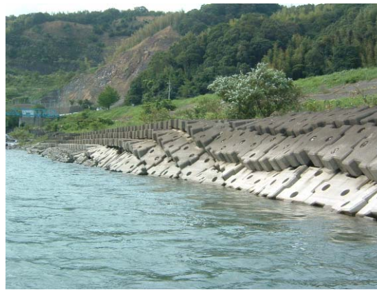
局所洗掘の被災状況（古毛箇所）
