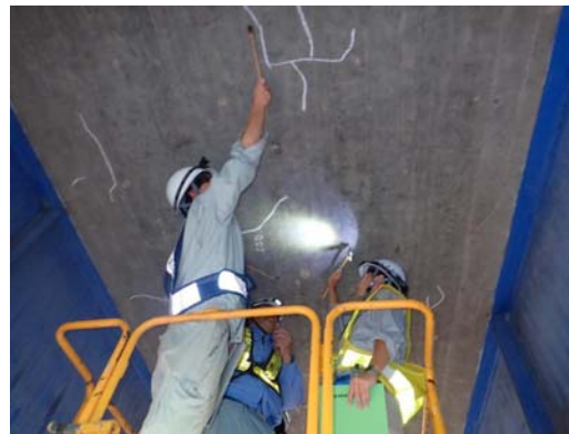
リフト車で近接目視点検
