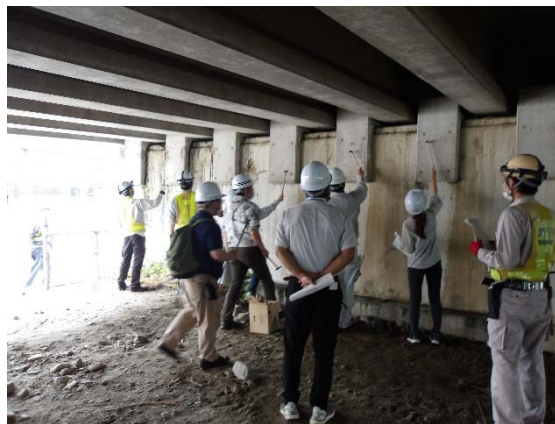
現地実習(打音点検状況)
