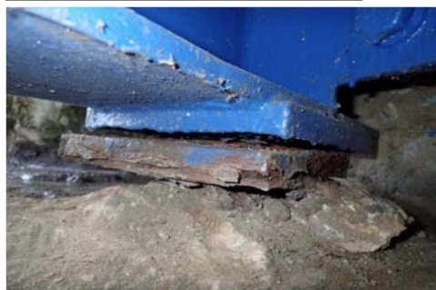
対策後 (支承及び沓座の取替補修)
