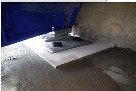
対策後 (支承及び沓座の取替補修)
