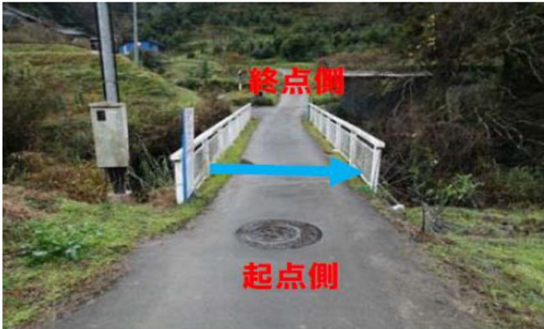
中御前橋全景
