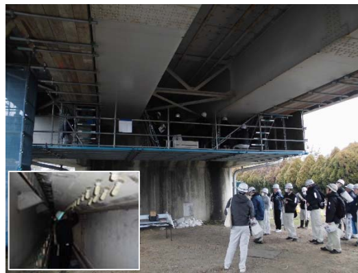
現地実習(床版補修工)
