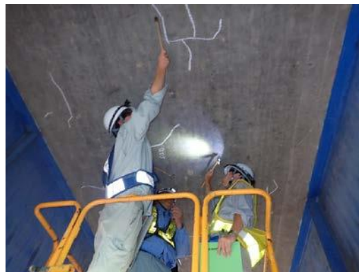
リフト車で近接目視点検
