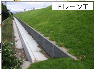
堤防漏水対策 (垣生地先)
