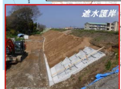
堤防漏水対策
