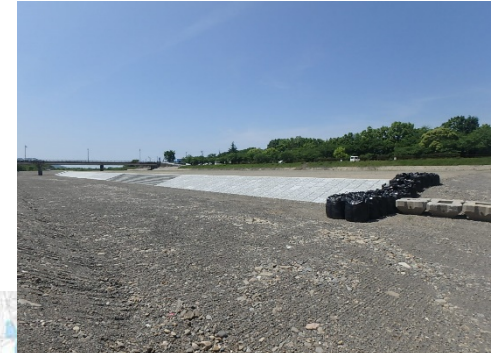
かわまちづくり (高水敷、低水護岸整備)
