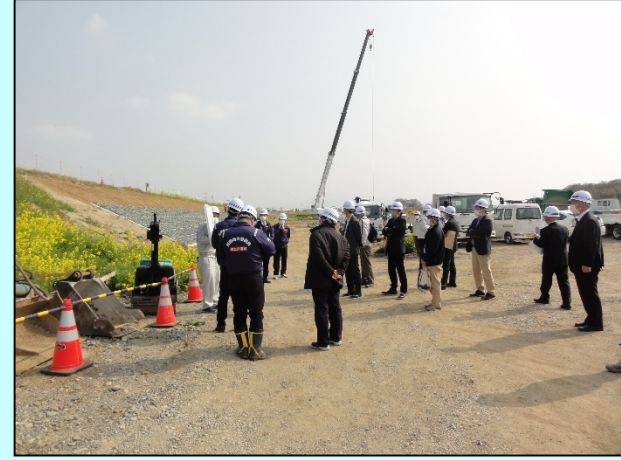
堤防漏水対策事業(垣生地区)
