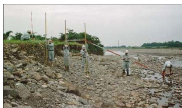
平成 13 年 6 月洪水(14.4k 左岸付近)
