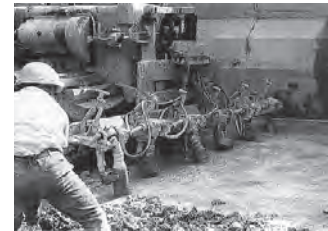
パイプロドザーによるコンクリート締固め
