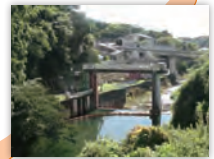
上水道取水堰
