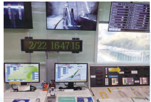
ダム操作卓 ダムのゲートを遠隔操作で行います。
