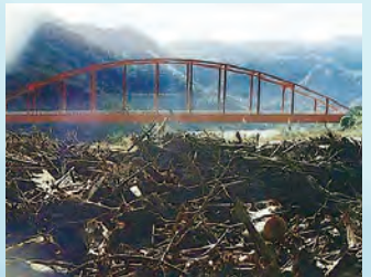
[S49] 流木の残骸 ダム上流の黒田橋付近
