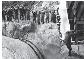
コンクリート本体打設開始
