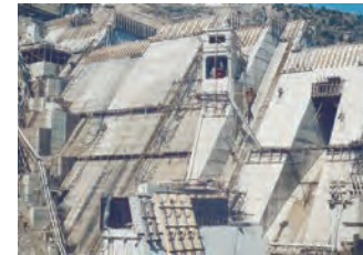
着々と進捗する工事
