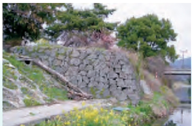
湯渡橋に残る鎌出し
