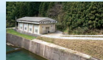
かんがい用水ポンプ場 ここから松山市内北部の畑に送られます。
