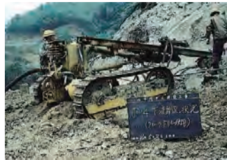
本体基礎掘削
