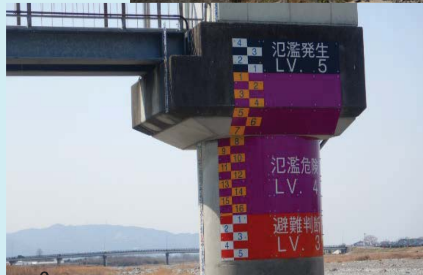
設置状況(近景)
