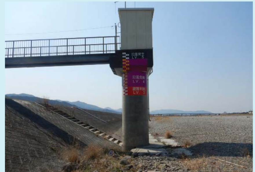
設置状況(遠景)
