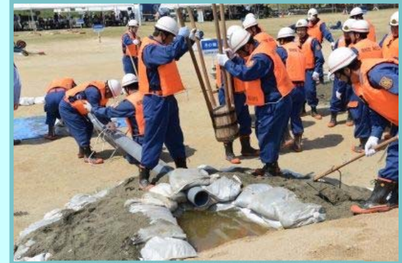
水防団による訓練(月の輪工)
