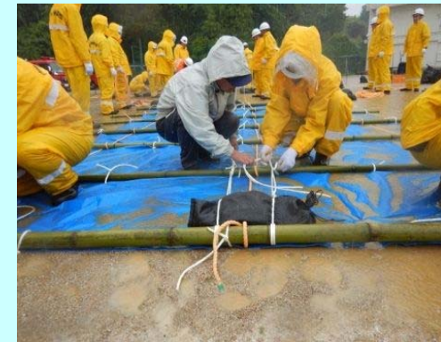
伊予市水防工法訓練 シート張り工の様子
