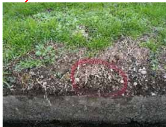
左岸3k/2付近
