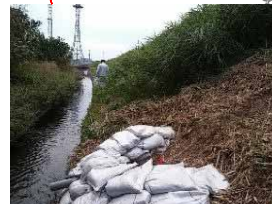
左岸4k/6付近
