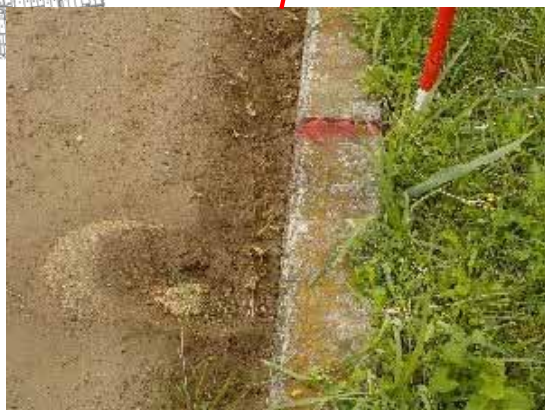
左岸1k/5付近
