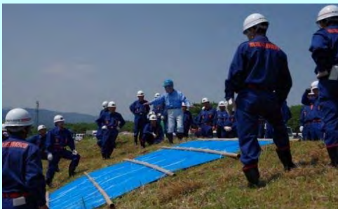
消防団員によるシート張工設置
