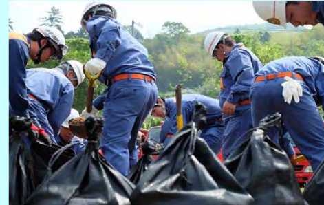
消防団員による土のう製作
