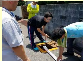
消火栓・消火ホース・ 防災用品点検の様子
