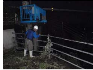
河川巡視状況
