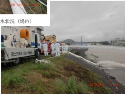
写真 排水ポンプ車による排水状況（堤外）
