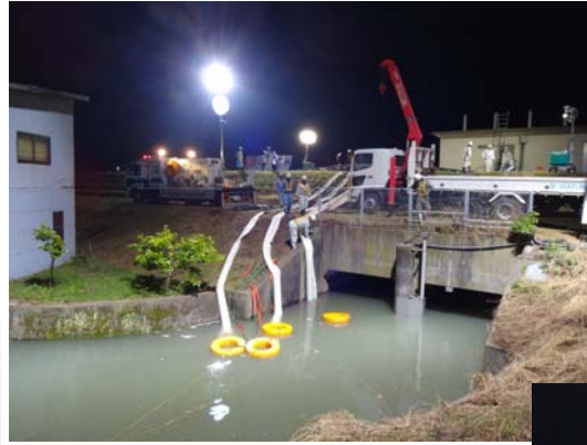
より実践的な排水ポンプ車の 夜間訓練
