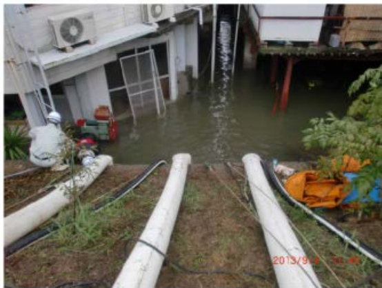
写真 排水ポンプ車による排水状況（堤内）
