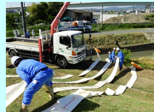
排水ホース展開・接続作業
