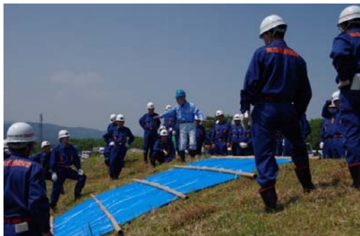
消防団員によるシート張工設置
