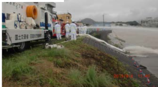
写真 排水ポンプ車による排水状況（堤外）
