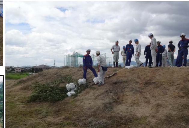
水防工法訓練の実施 (H27.7.12) 洗掘対策に有効な木流し工法
