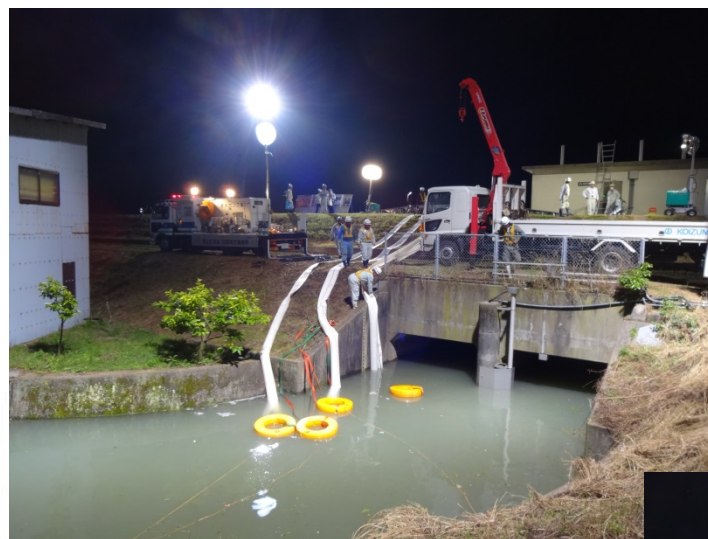
より実践的な排水ポンプ車の 夜間訓練
