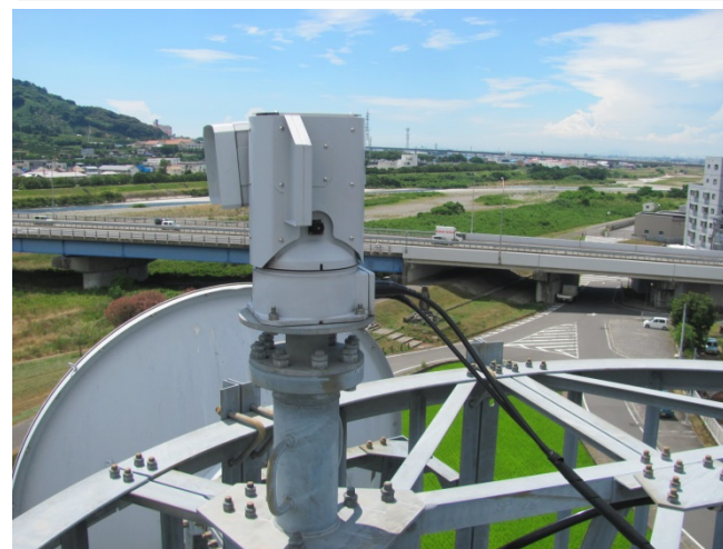
洪水に対してリスクの高い箇所を監視するためのCCTVカメラの整備
