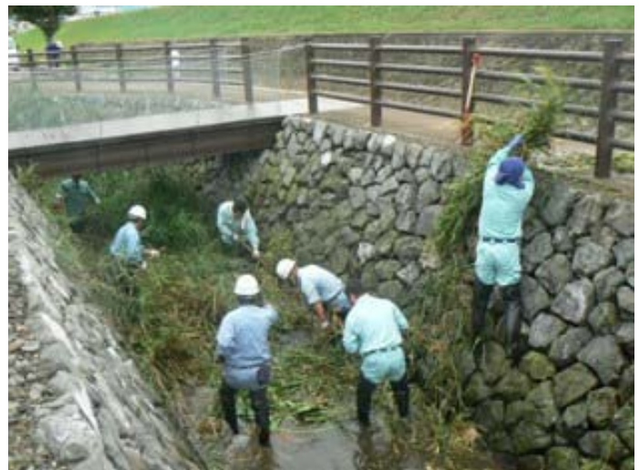
ツルヨシ除去状況
