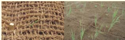
ヨシ生育基盤面の侵食防止対策として、ヤシ繊維製の土砂流出防止ネットを設置しました。
