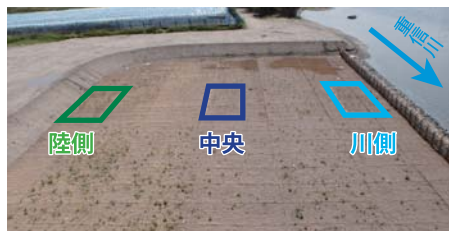
モニタリング実施箇所
