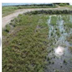
施工後約5ヶ月(H21.8.20)
