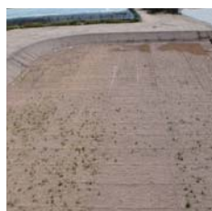
施工後約2ヶ月(H21.5.13)
