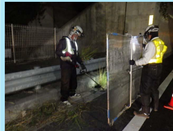
維持作業(除草)
