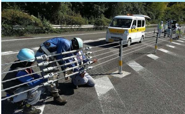
点検作業(防護柵)
