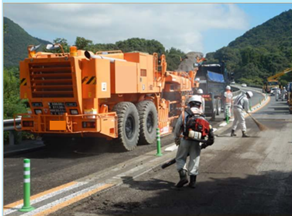
補修工事(舗装)
