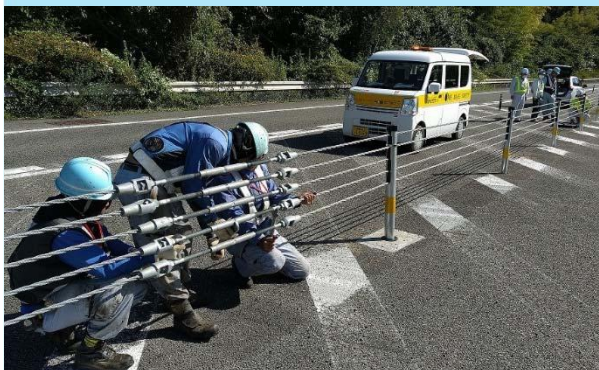
点検作業(防護柵)
