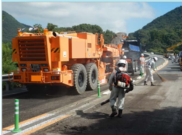
補修工事(舗装)
