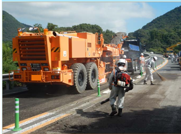
補修工事(舗装)
