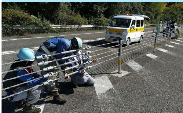
点検作業(防護柵)
