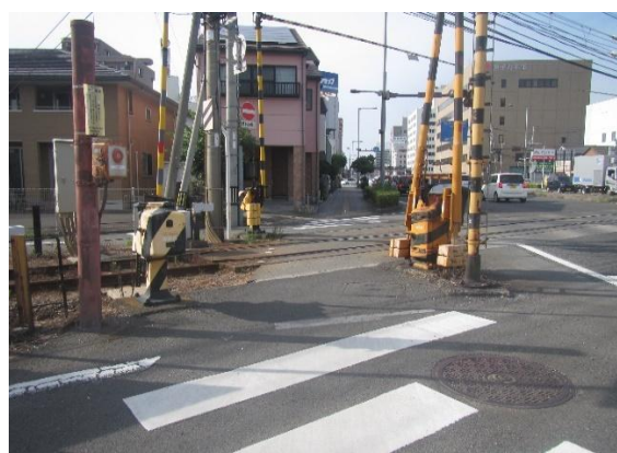
藤原町踏切道（北進方向 西側）
