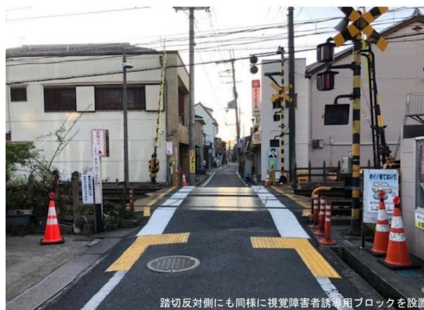
踏切反対側にも同様に視覚障害者誘導用ブロックを設置
