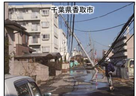
【沿道民地の電柱が倒壊し道路閉塞した例】
