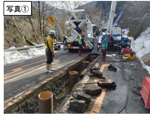
写真① コンクリート打設状況
