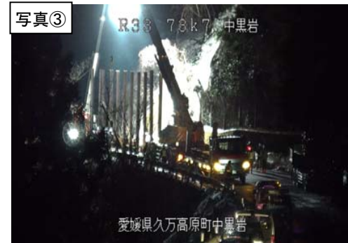
写真③ H鋼建込み状況
