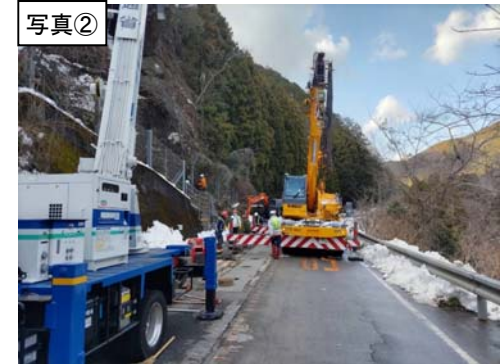
写真② 鋼矢板搬入状況
