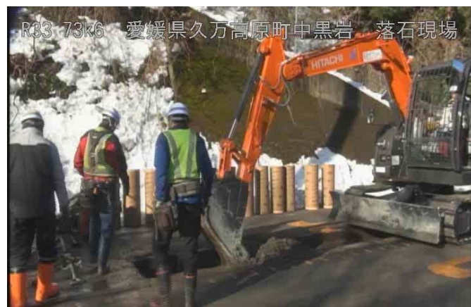
掘削状況②
