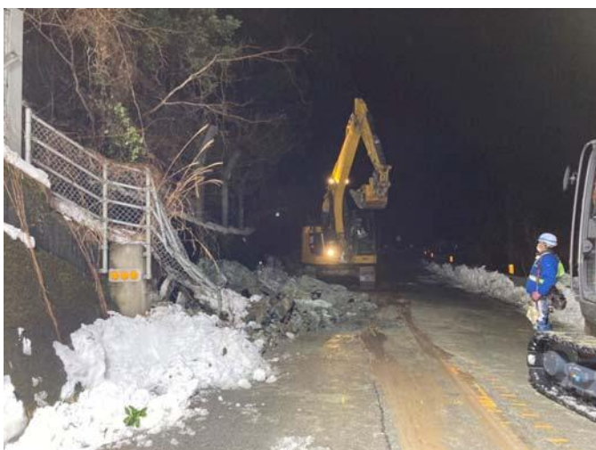
破碎岩撤去状況
