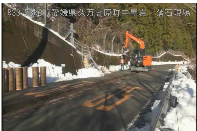
掘削状況①
