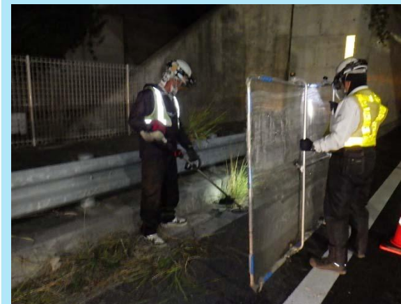
維持作業(除草)
